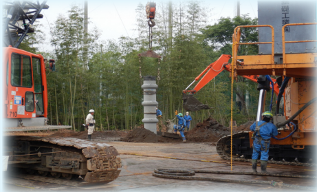
コンクリート杭を埋める作業
