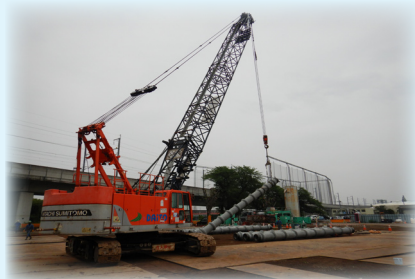
クレーンで杭を吊っています！！
