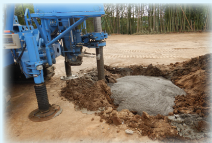
コンクリートを流し込んでいます！
