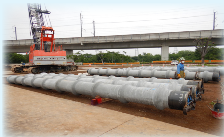
埋めるコンクリート杭
